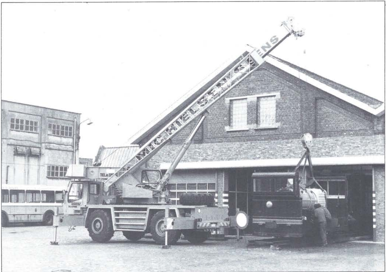
Het terug in de machine plaatsen van de herstellde stoomketel. Merksem, Oude Bareel; 18.06.86.
